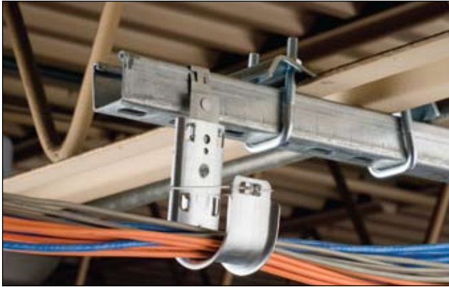
Assemblage pour reprise sur ERISTRUT (181082 + 181063)
