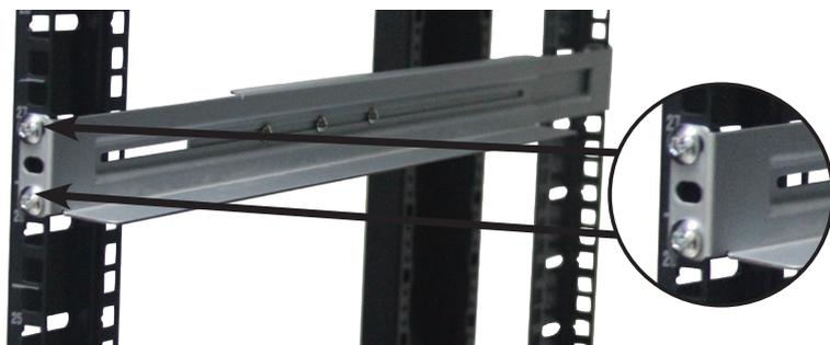
**2 : Intégrer l'appareil, retirer la vis du bas du rail ajustable.**
